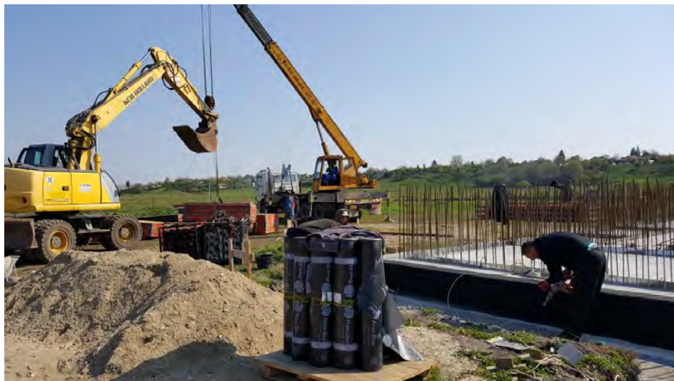
Foto nr. 9 – Șantier Stație de epurare – sistem de canalizare, comuna Măgura
